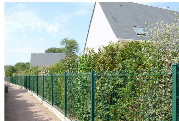
😞 Clôture implantée côté extérieur du lot privé
