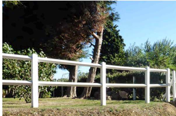
😊 Clôture normande en béton
