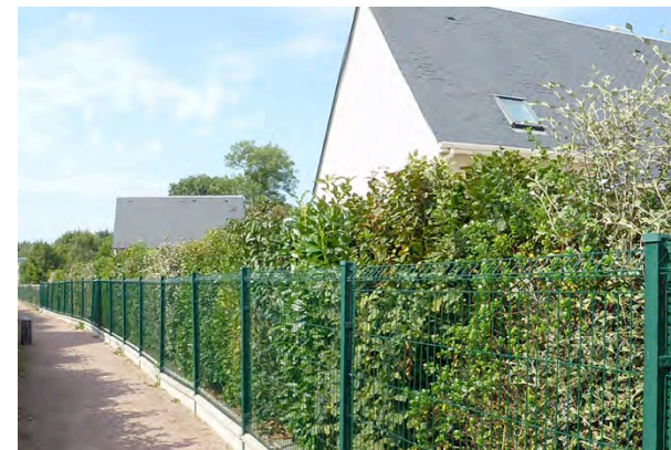
☹️ Clôture implantée côté extérieur du lot privé
