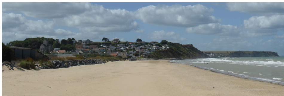
Abaissement des falaises et estran sableux, commune de Saint-Côme-de-Fresné
