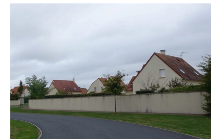
Murs hauts et enduits
