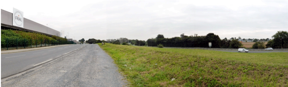
Zones d'activités et infrastructure, commune de Saint-Martin-des-Entrées
