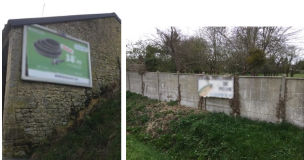
Dispositifs en mauvais état d'entretien, Vaux-sur-Seulles et Bayeux, 2018
