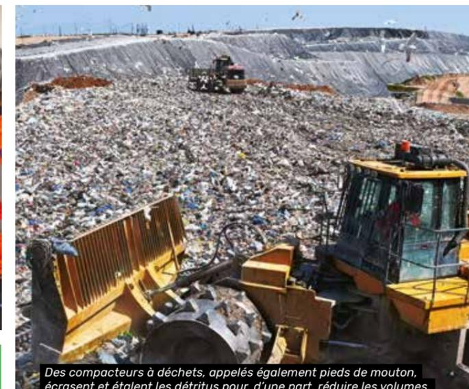
Des compacteurs à déchets, appelés également pieds de mouton, écrasent et étalent les détritiques pour, d'une part, réduire les volumes, et d'autre part, atténuer les odeurs. Les déchets montent progressivement, pouvant atteindre une hauteur maximale de 22 mètres par rapport au bas du casier.
